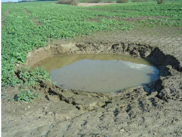
Abbildung 3-36: Trichterbildung im Rapsacker auf einer Leitungstrasse bei Niendorf, Foto: WBV Warnow-Beke
