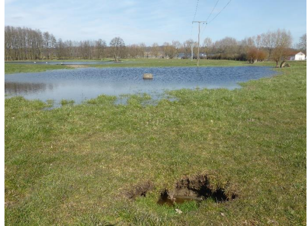
Abbildung 3-37: Trichterbildung mit ausgedehntem Rückstau bei Wendorf, Foto: WBV Warnow-Beke
