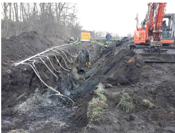
Abbildung 3-40: Reparatur einer Leitung bei Dummerstorf nach Trichterbildung, Foto: WBV Untere Warnow-Küste
