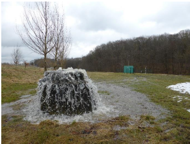
Abbildung 3-38: Hochwasserüberlastung an einem Bekezufluss bei Klein Gischow, Foto: WBV Warnow-Beke
